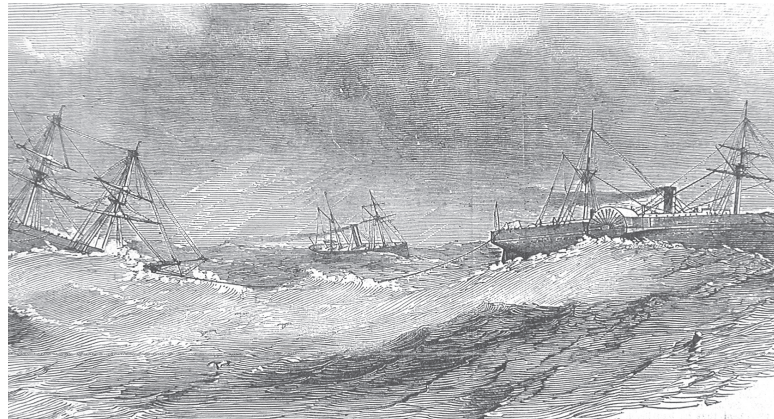
1.40 Installation de la ligne télégraphique entre Terre-Neuve et l'île du Cap-Breton
