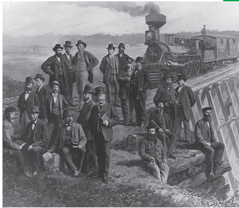
2.16 Le réseau ferroviaire
